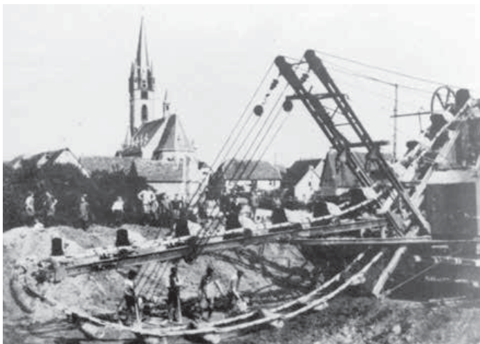
Baggerarbeiten für das neue Bachbett 1926
