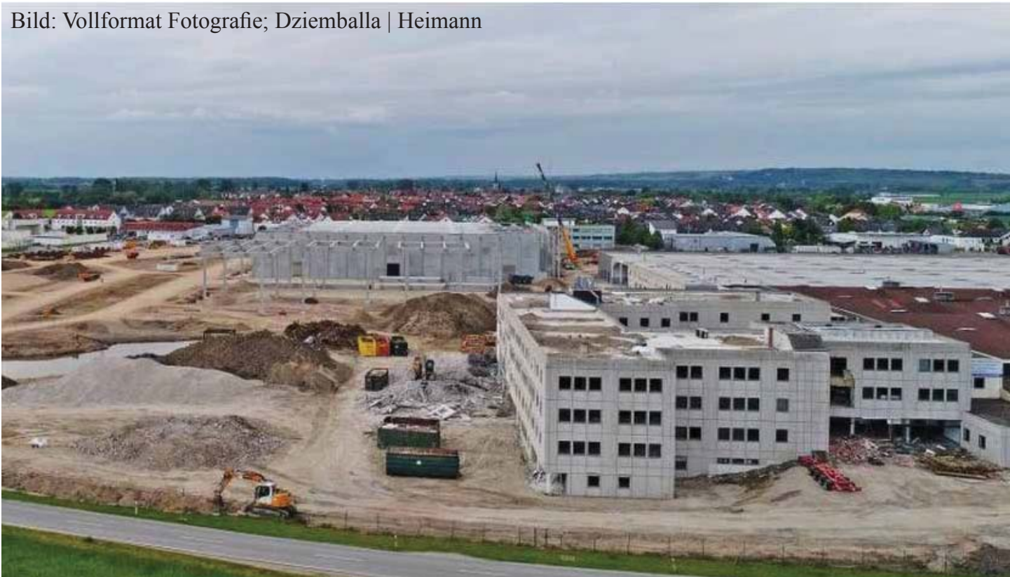
Das ehemalige Mitsubishi-Gelände während der Umbauphase zum Logistikzentrum. Im Hintergrund weitere neue Hallen und im Vordergrund das Mitsubishi Verwaltungsgebäude.
