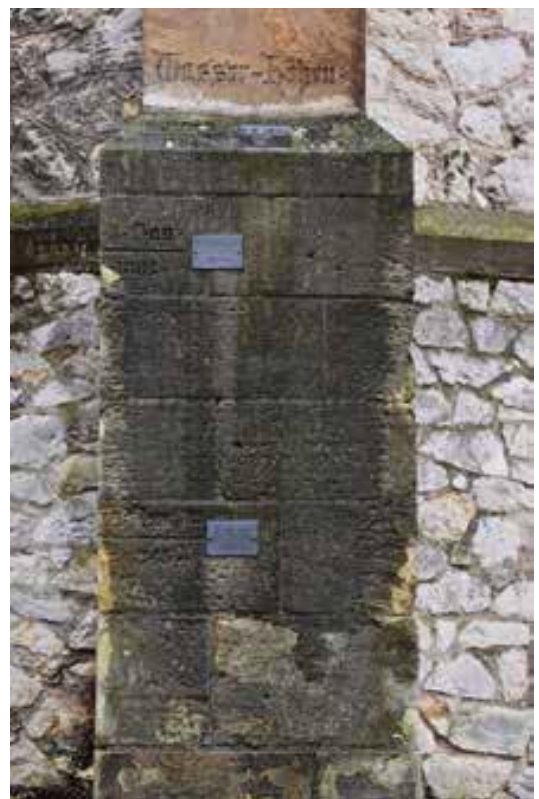
An einem Stützpfiler der Nordseite der Evangelischen Kirche sind die Hochwasserstände von 1845, 1883 und der Rekordstand von 1874 eingemeißelt
