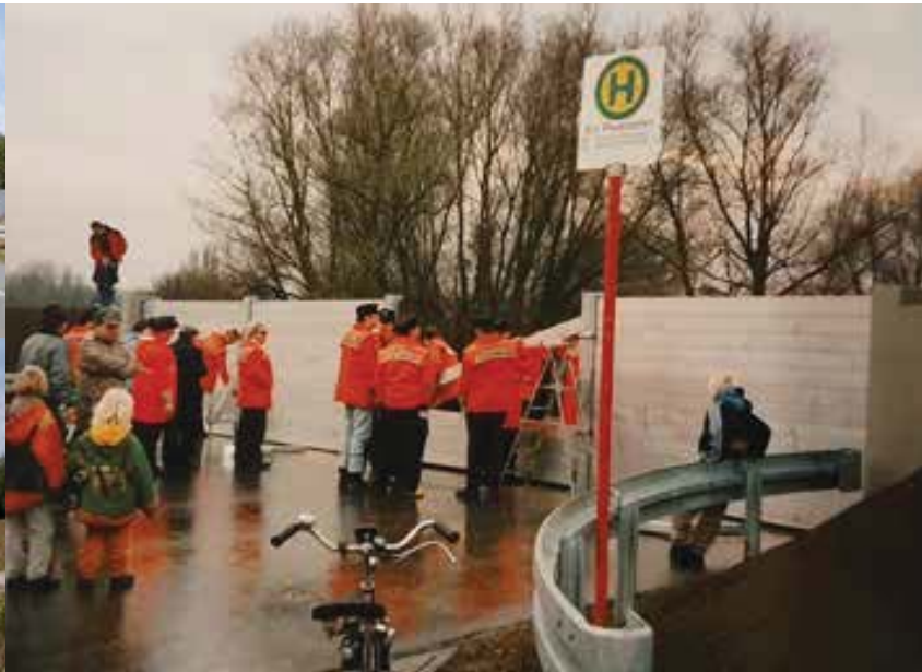
Der erste Aufbau des neuen Dammtors an der Deichscharte Kornsand
