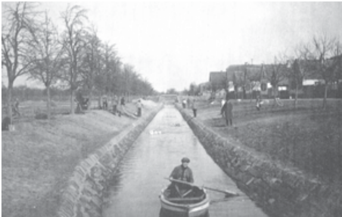
Die „neue Bach“ 1926 mit ausgemauertem Kanal aus roten Sandsteinen
